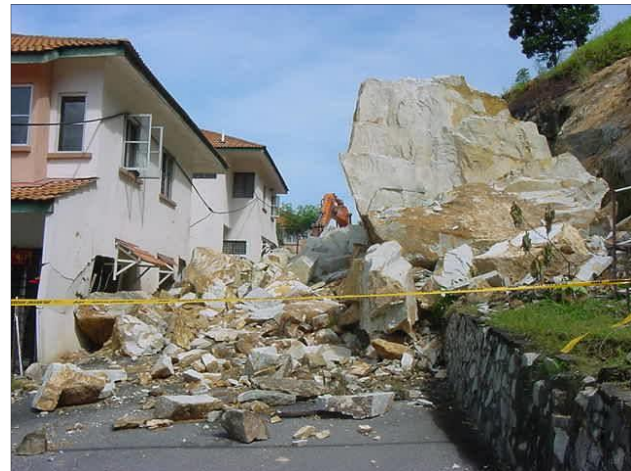
Rajah 2 Kejadian tanah runtuh dalam bentuk jatuhan batuan yang telah mendatangkan kemusnahan kepada harta benda. Sebelum jatuhan batuan berlaku, blok batuan tersebut diistilahkan berada dalam keadaan bahaya dan apabila kejadian berlaku, keadaan tersebut dikategorikan sebagai bencana atau geobencana. (Gambar oleh Jabatan Mineral dan Geosains Selangor).
