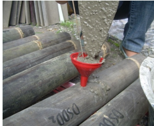
(b) Pouring cement mortar
