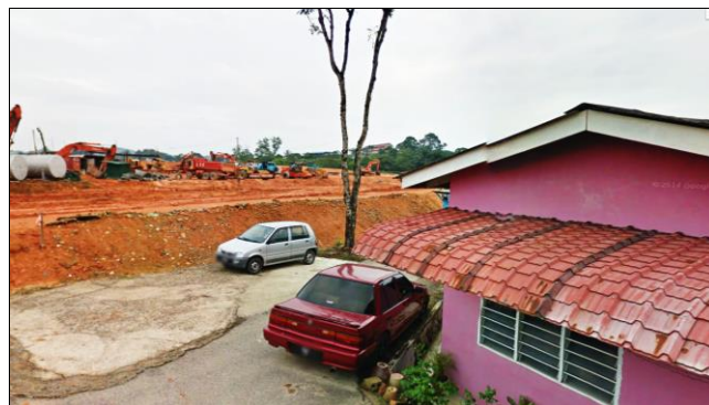
b) Kampung Melayu Lima Kedai (earthworks)
