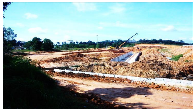
e) Taman Kempas Utama (earthworks)
